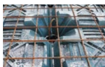
Verstärkung der Säulen mit Stahlgabeln
